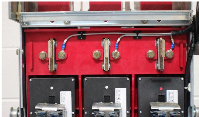
Conexiones de voltaje del lado de línea en el disyuntor DS (sin dedos)
