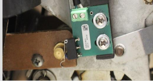
Interrupción de límite instalado para permitir la detección de Sluggish Breaker® e indicación de posición del interruptor
